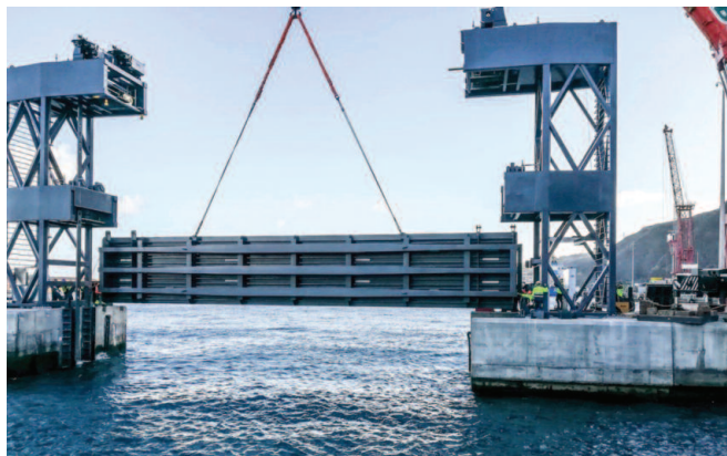
New gate, Marina La Palma Calero Marinas
